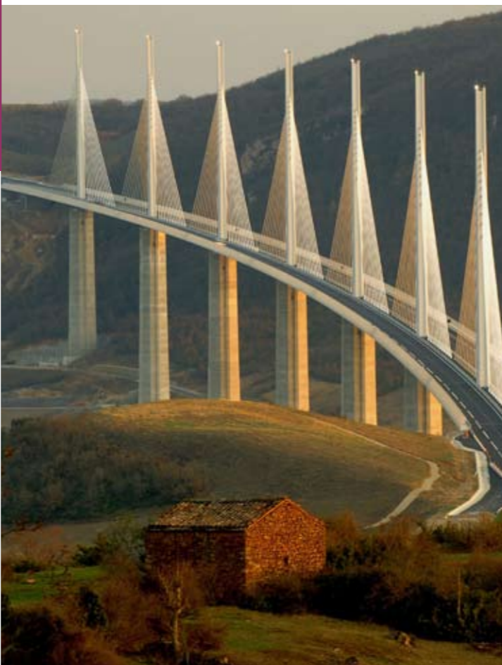
Viaduc de Millau (Architecte : Norman Foster)
